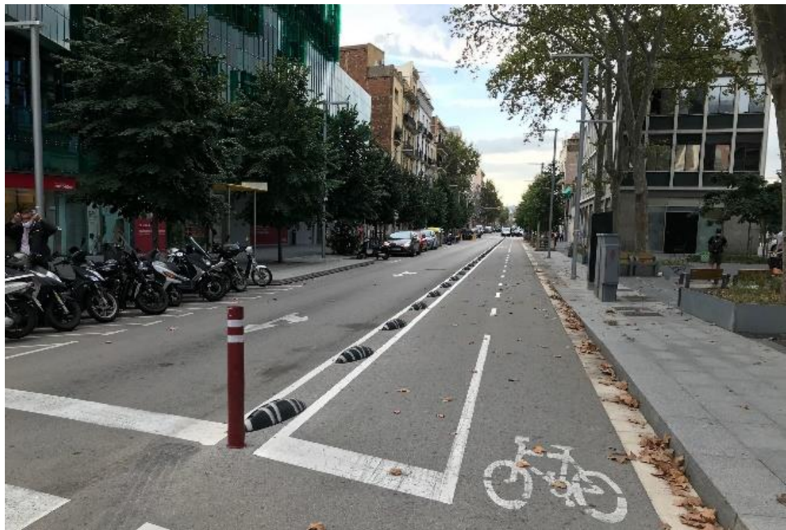
Abbildung 6: Neuer (allerdings zu schmaler) Zweirichtungsradweg in Poblenou
