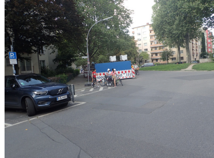
Baustelle im Bereich des Barbarossaplatzes
