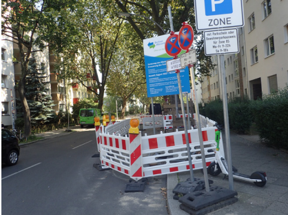
Baustelle im Bereich der Barbarossastraße
