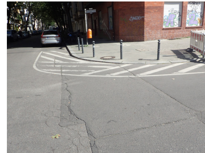
Markierung Sperrfläche an Einmündungsbereich
