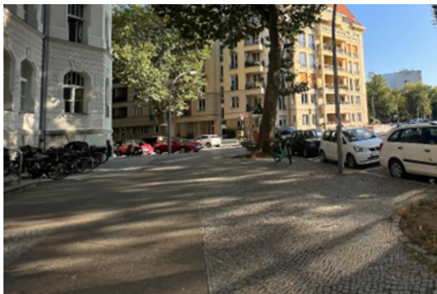
befestigte Gehwege (Gehwegplatten und Mosaikpflaster), TOPOS, 2023
