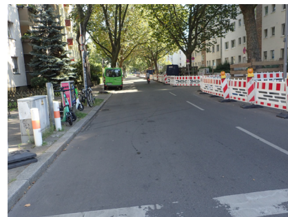
Baustelle im Bereich der Barbarossastraße und „wild“ abgestellte Räder und Tretroller
